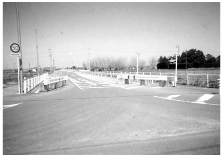
なかなか進まない広域農道（早尾町地区）
