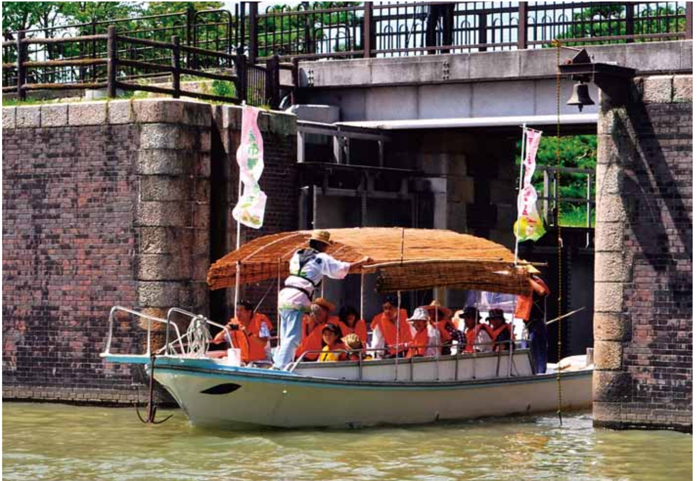
国定重要文化財を巡る(船頭平閘門) (あいさい写真クラブ提供)
