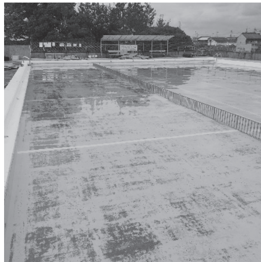
▲佐屋西小学校プール
