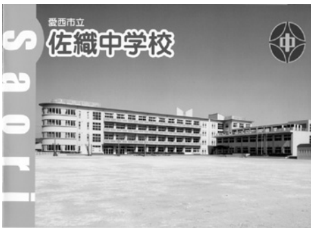
▲防犯カメラが設置してある佐織中学校
