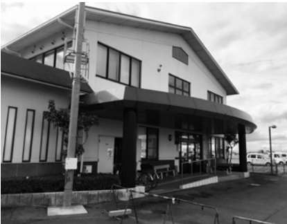
▲無料が有料に (立田南部地区防災コミュニティセンター)
