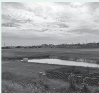
▲企業用地造成現場(南河田町)
