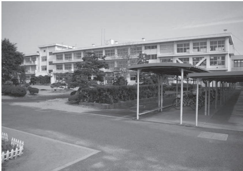
▲統廃合が検討されている八開中学校
