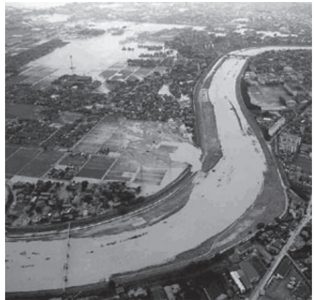
▲氾濫している河川（国土交通省出典、新潟県五十嵐川）
