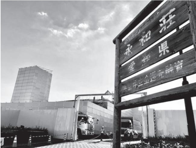
▲解体工事が進む永和荘跡地
