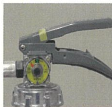
× 安全栓の脱落
