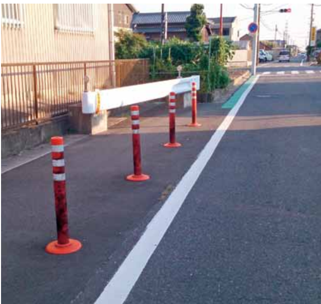
▲歩道が突然なくなる危険な通学路(北一色町)
