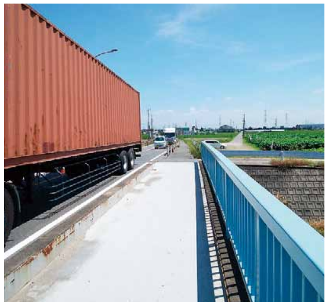
▲危険を感じている県道の橋(道の駅東)
