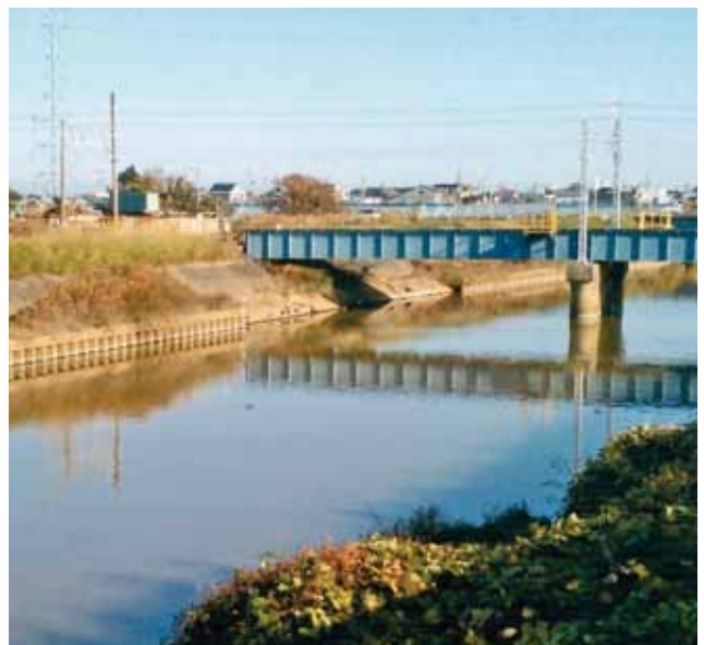
▲領内川にかかる尾西線の名鉄橋(町方町地内)
