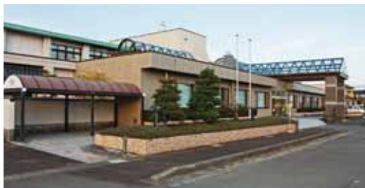
▲お風呂の修繕がされる八開総合福祉センター
