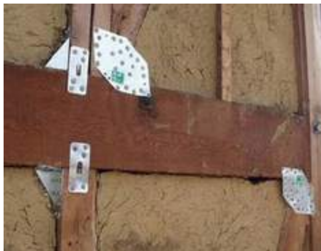
<耐震改修の一例>
