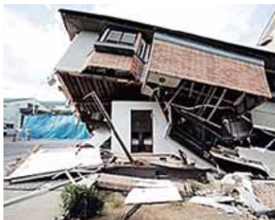
耐震シェルター 一例
