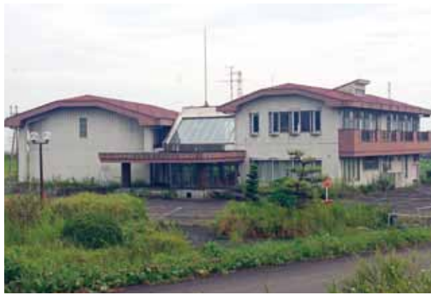
▲取り壊される農村環境改善センター
