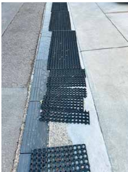
▲宅地開発で後退し未整備の土地(黒いゴムの下)
