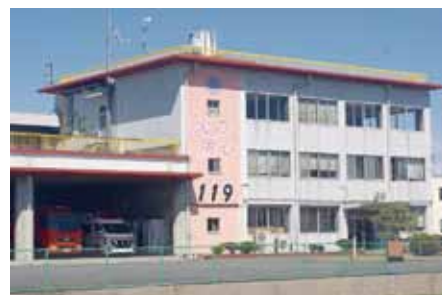
▲改修される消防庁舎
