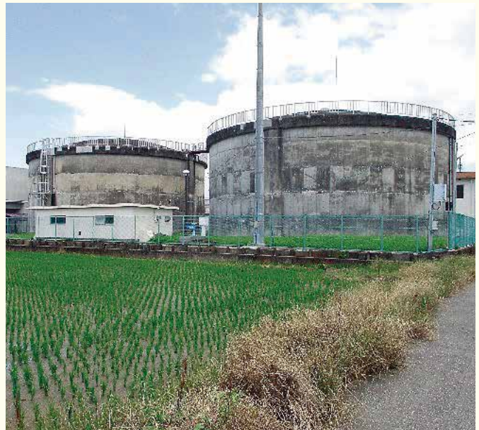
佐織中部浄水場 配水池
