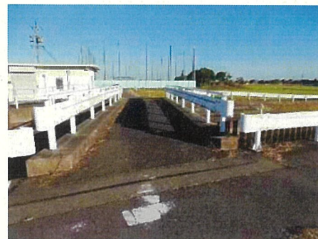
写真 点検対象箇所
