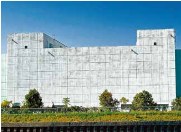
▲屋根の中央が凹んだ構造の永和中学校体育館の外観
