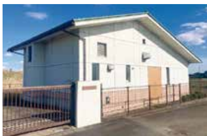
▲西八幡団地浄化センター
