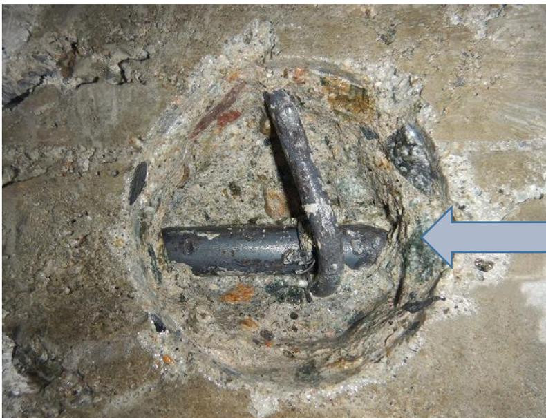
建物内のコンクリートをはつり、鉄筋の腐食度を確認しています。
