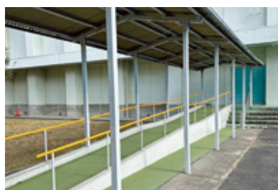
▲市江小学校のスロープ
